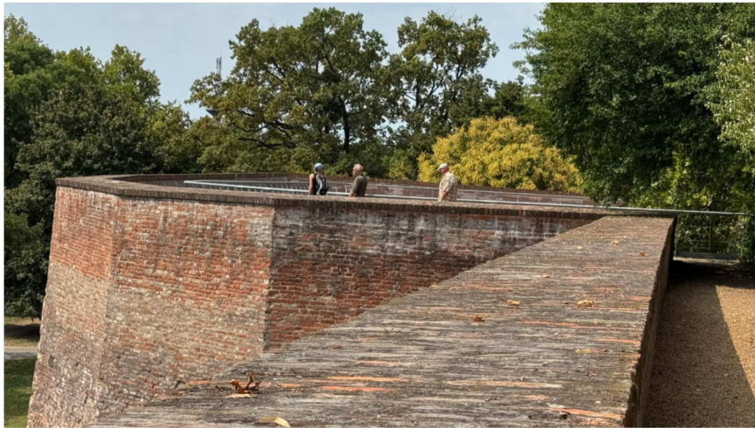
Burg Rundgang auf der Umfangsmauer
